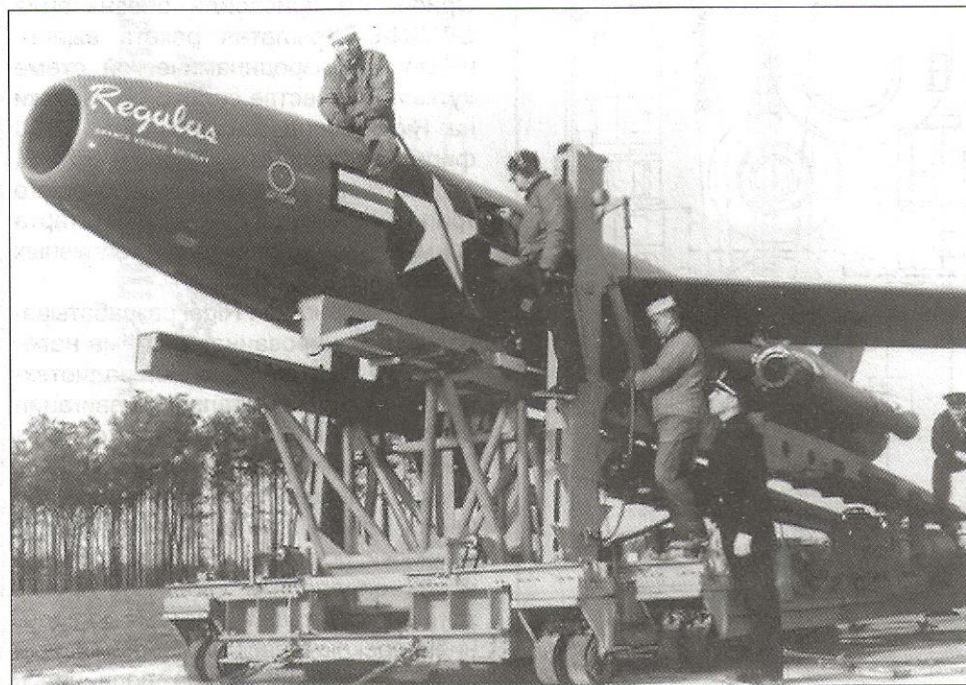
Подготовка крылатой ракеты Regulus к запуску с наземной пусковой установки
